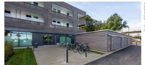
Fahrradabstellanlagen gemäß MobBauOG bei GEWOBA Neubau
